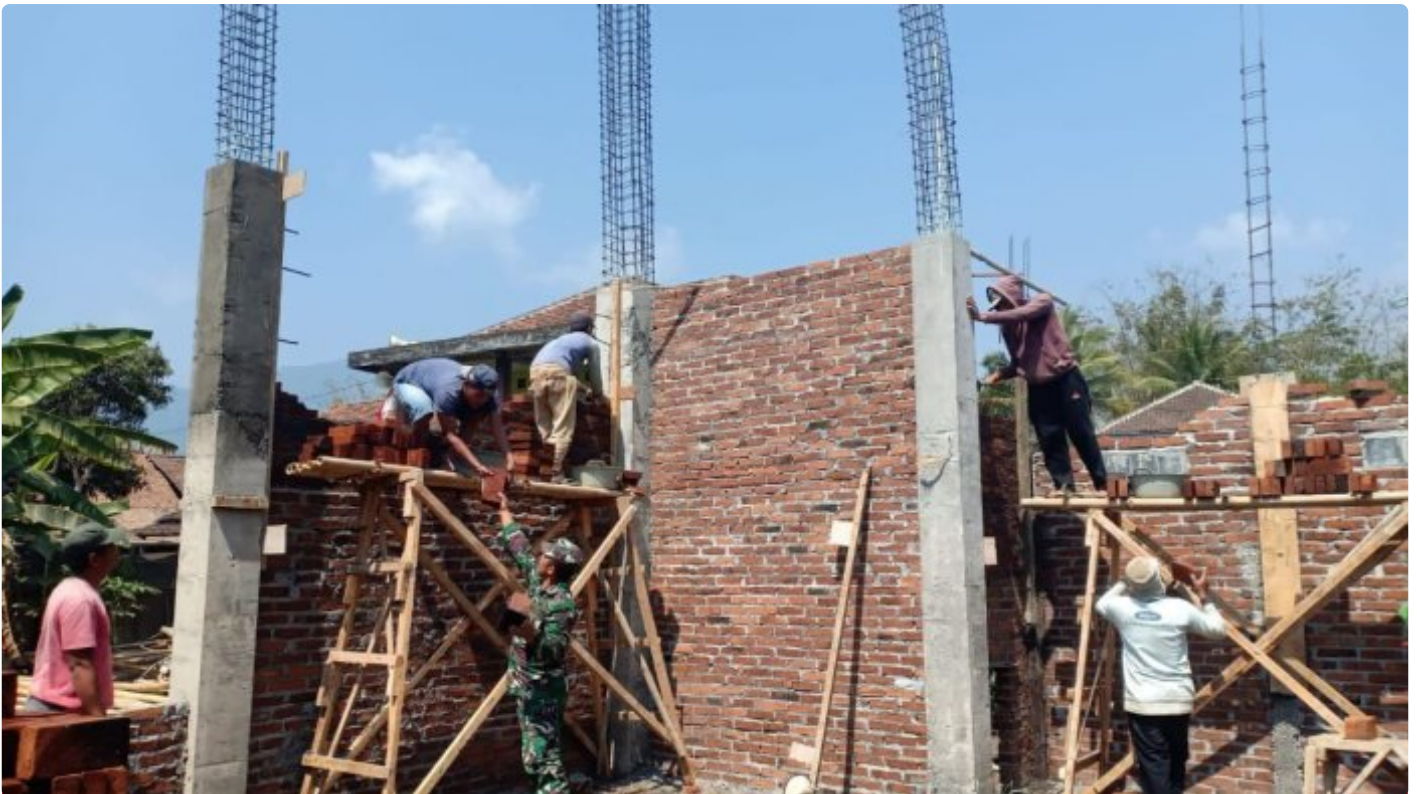
Anggota Koramil 04 Windusari Serda Nasikin kerja bakti bantu pembangunan Masjid
